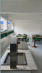
Instalação de refeitório
